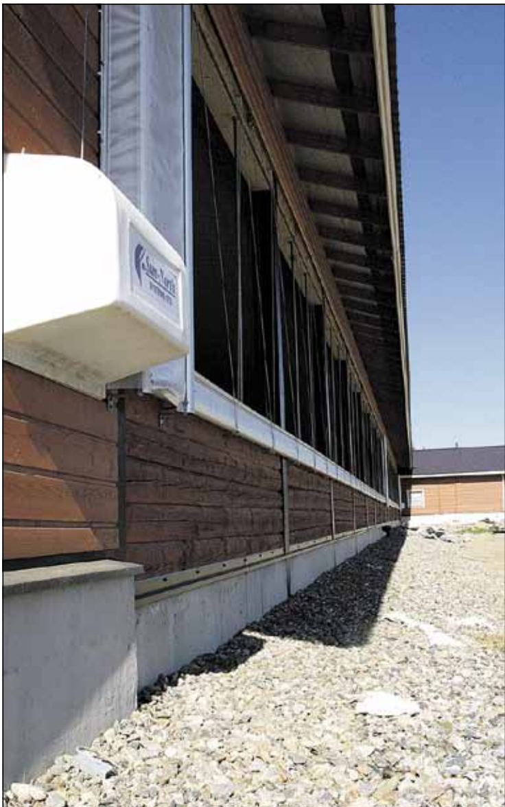
Tilan uusi karjasuoja on Savonrannan ensimmäinen robottinavetta. Valtakunnallisen tyyppinavettahankkeen pilottirakennuksista se eroaa muista siinä, että seinien alaosa on kotimetsästä korjatusta puusta sahattua hirttä.
