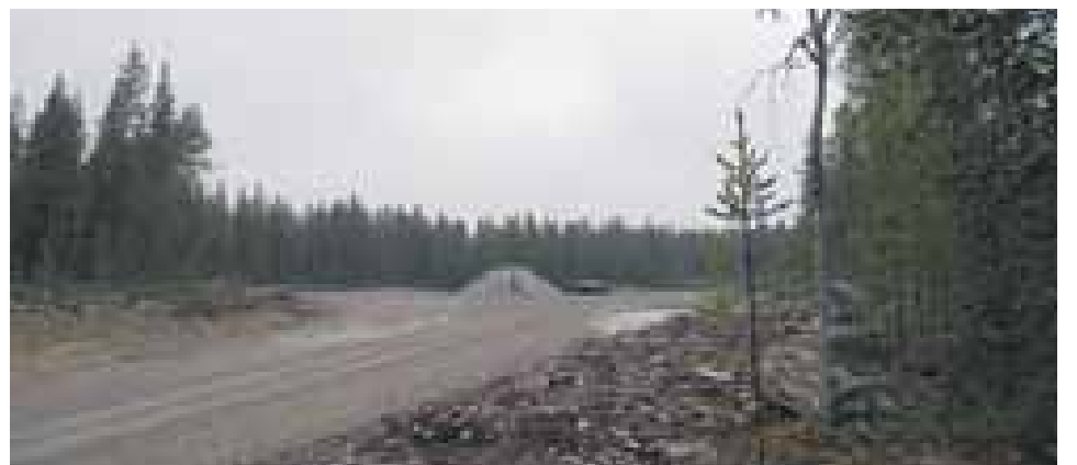
Tuulivoimala vaatii 0,5 ha pystytysalueen ja raskaita kuljetuksia kestävästi tieverkoston rakentamiseen ja lisäksi maakaapeloinnin. Tarvittava maa-aines pyritään hankkimaan ja murskaamaan alueelta. Kyse on teollisuuslaitoksen pystyttämistä.
