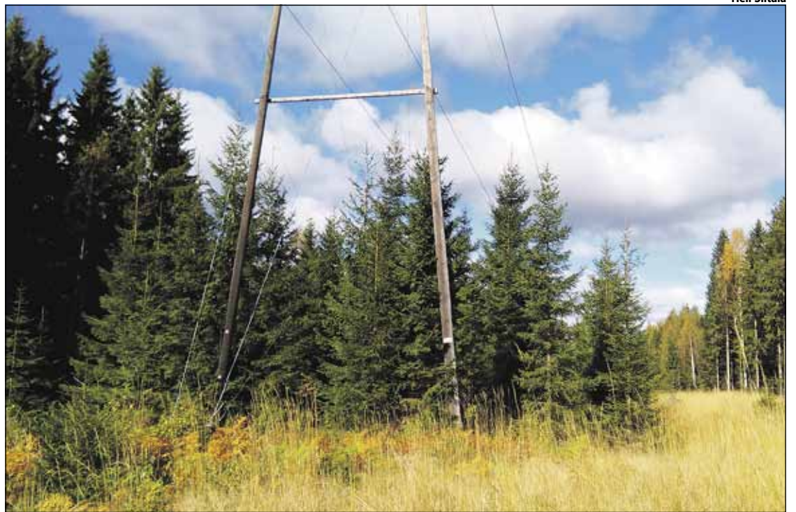
Ylipitkäksi kasvaneet kuuset, jotka kurottavat jo voimajohtojen välissä, ovat vaarallisia ja aiheuttavat virrankatkaisun poiston ajaksi.
